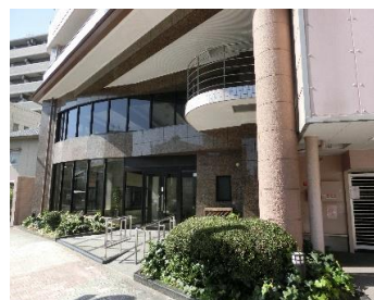
▲外エントランス
